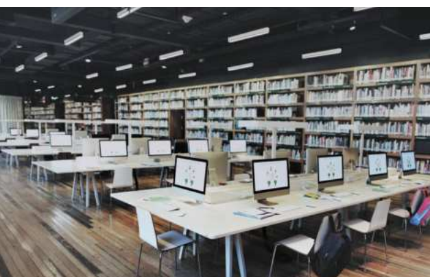
Luminaire suspendu au-dessus des postes de travail dans la bibliothèque avec éclairage indirect RGB+WW 200112
