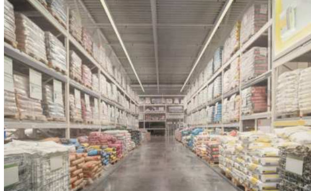
Double bande lumineuse asymétrique dans un magasin de bricolage 200109
