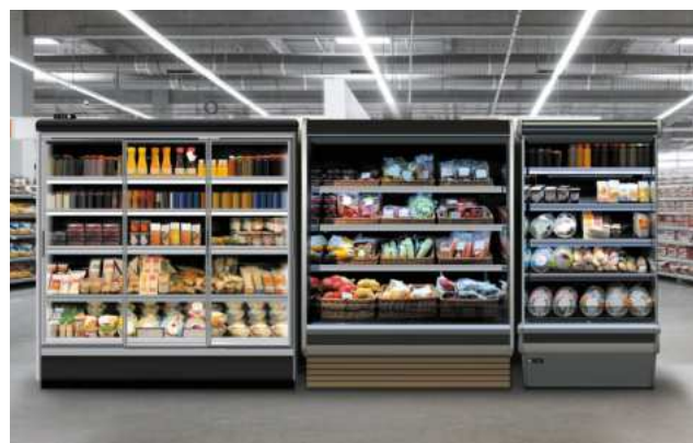
Luminaire linéaire asymétrique dans un supermarché 200108
