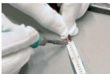
Assemblaggio di stripe LED
