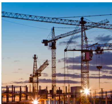
Gru per edifici
